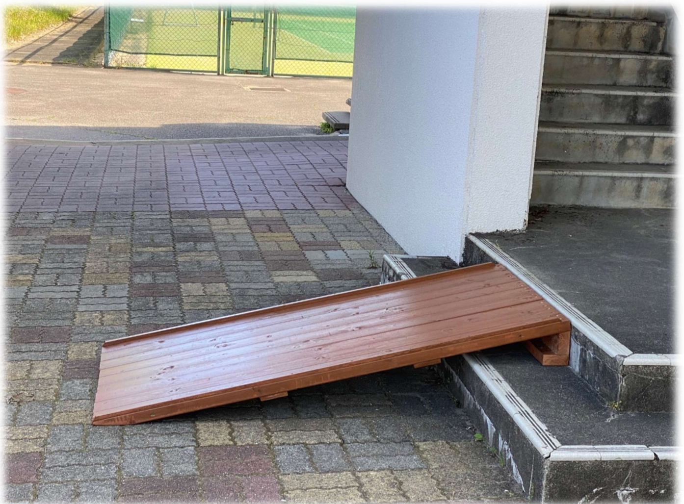
【作製していただいたスロープ】
