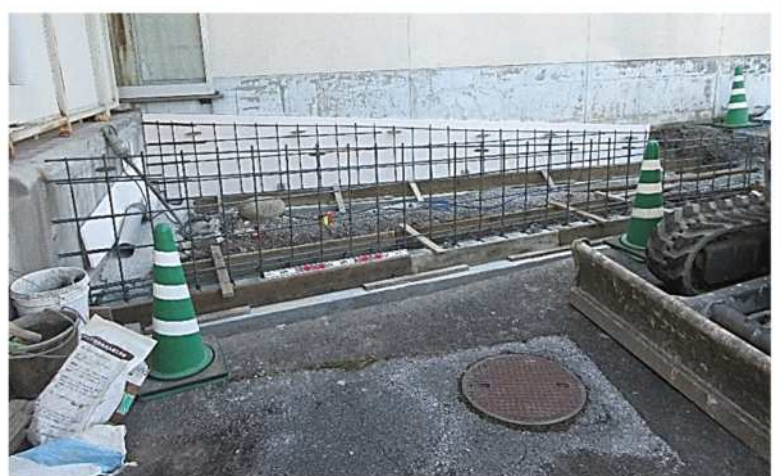
校舎東側スロープ設置工事
