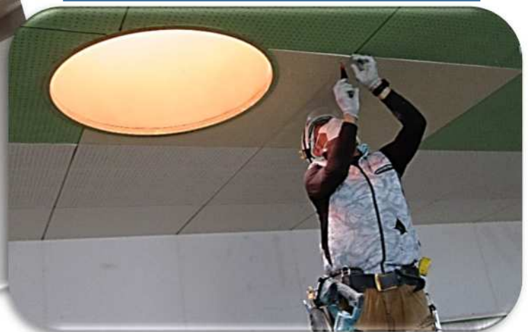
3F ホールの天井板の付け替え
