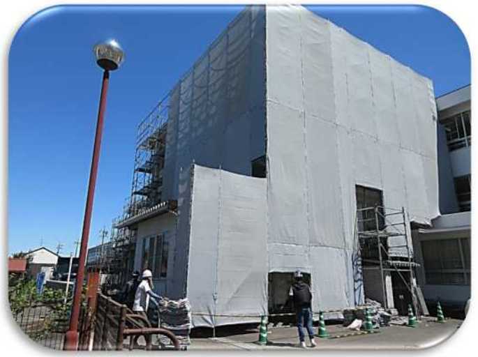
外部足場とメッシュシートで覆われた校舎北西面
