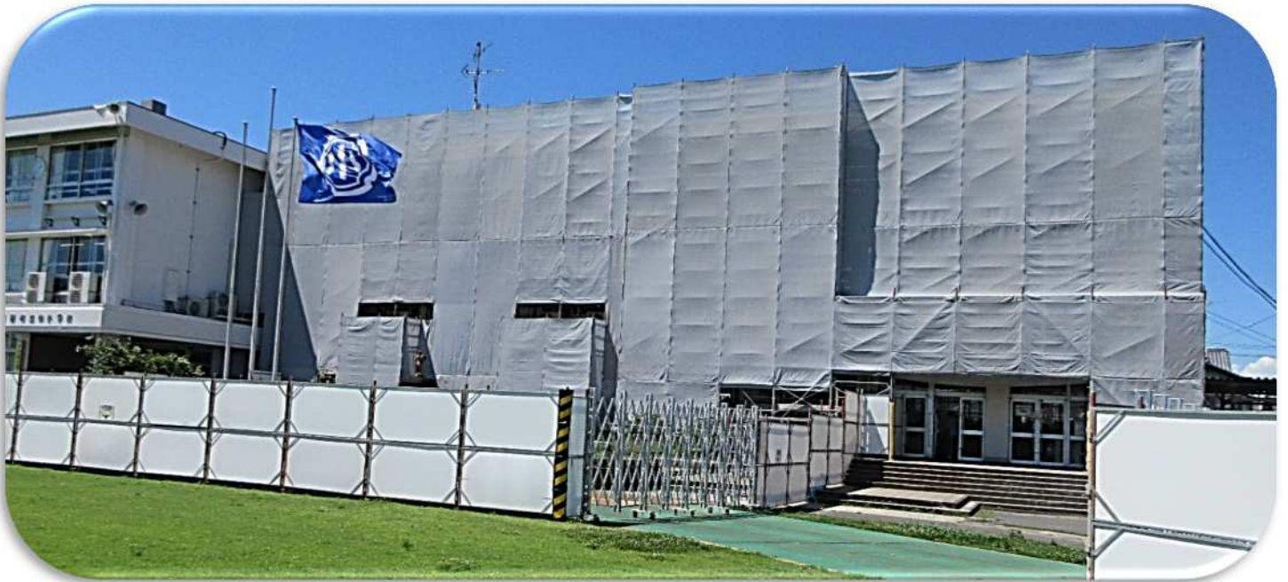
外部足場とメッシュシートで覆われた校舎南面
