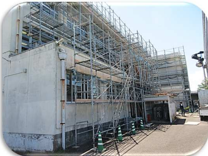
外部足場が組み上がった校舎北東面
