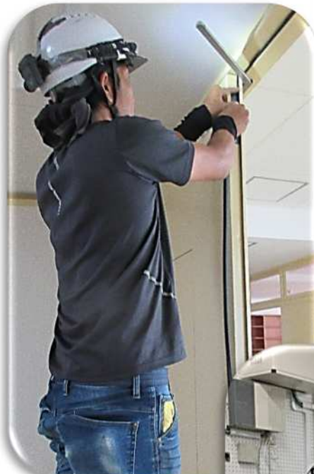
防火扉の仕上げ
