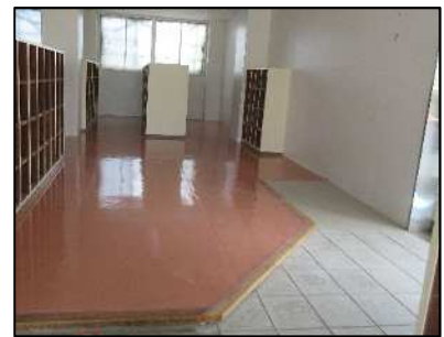
スロープが設置された児童玄関
